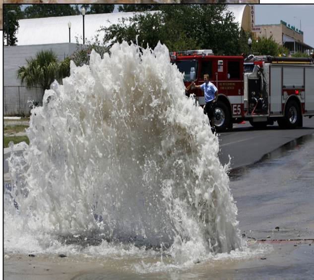
شکل ۱-۱: نشت در یک انشعاب و یک خط انتقال از شبکه توزیع
